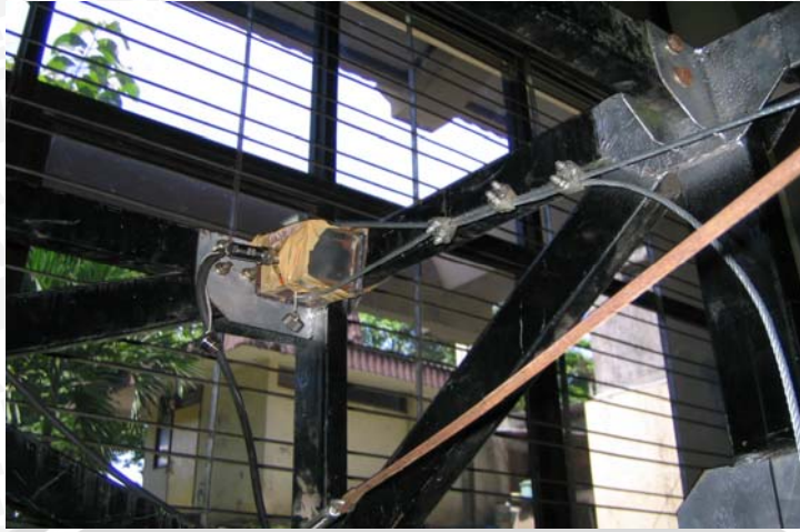
Pemasangan loadcell pada dudukannya
