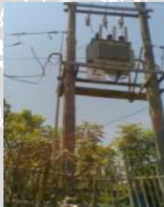
Gambar 4. 22 Salah Satu Travo Yang Terdapat Di Desa Slopeng Yang Mengalirkan Listrik Ke Seluruh Warga Desa Slopeng
