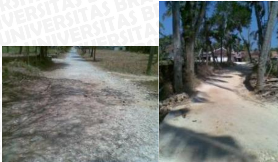
Gambar 4. 21 Kondisi jalan rusak dan jalan berupa perkerasan tanah di Desa Slopeng
