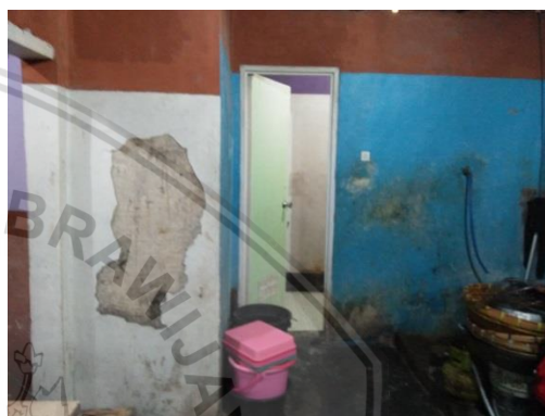
Gambar 12. WC dan kran air
