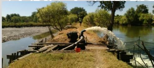
**Gambar 11 Pompa air bekerja pada proses pengeringan**
