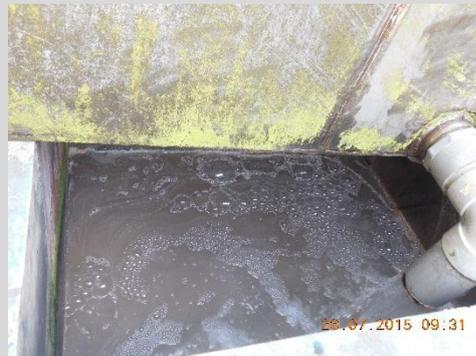
**Gambar 66.** Pengolahan di bak *equalizer*
