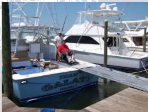
**Gambar 44.** Ramp Pontoon untuk akses difable
