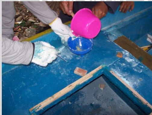
Gambar 11. Pengecoran Lapisan Insulasi
