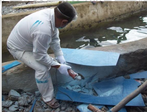
Gambar 9. Pembuatan Plat Fiberglass Palka
