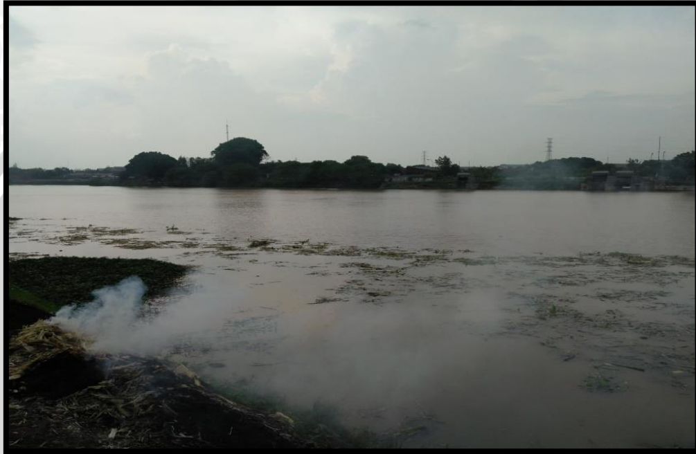
Gambar 3. Kondisi Bendung Rolak Songo
