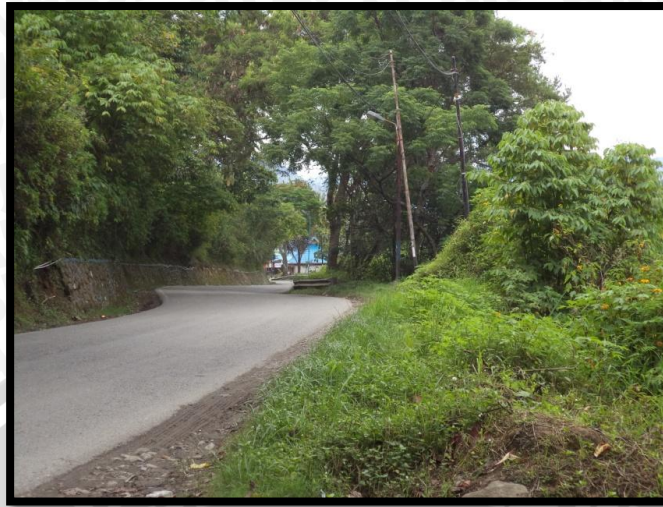
Gambar 7. Fasilitas Prasarana Jalan Raya (Data Primer,2016)
