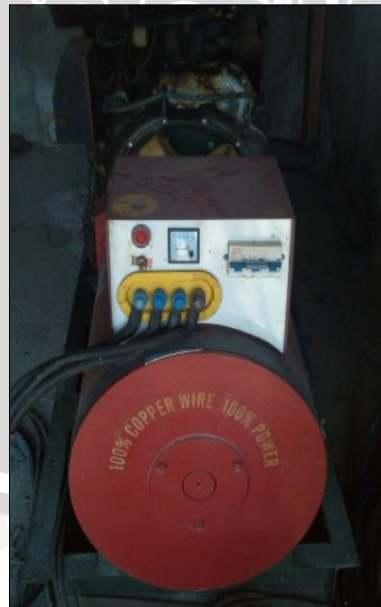
Gambar7. Generator set daya listrik mencapai 10.000 watt sebagai suplai arus listrik saat terjadi pemadaman arus listrik.
