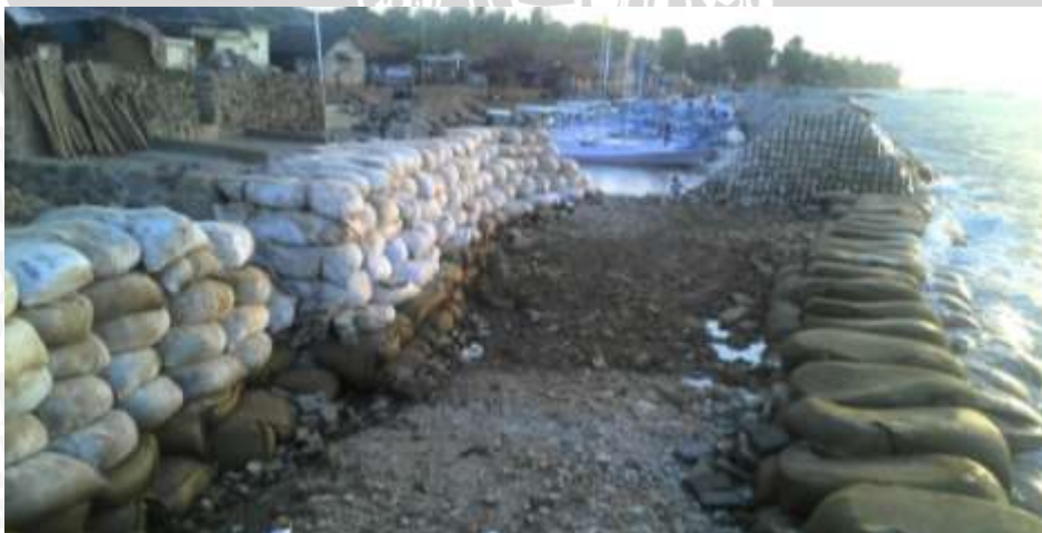
Gambar 28. Bangunan Seawal/dan parkir kapal.
