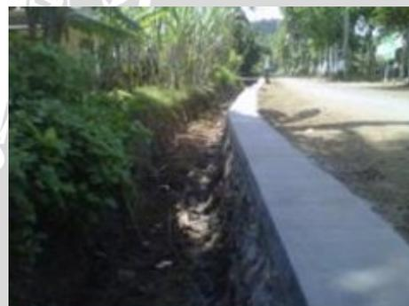
Gambar 71. Kondisi setelah dibuat plengsengan
