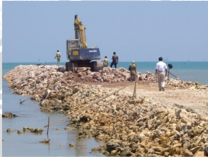
Gambar 2. Proyek pembangunan breakwater sisi barat PPI Banyusangka
