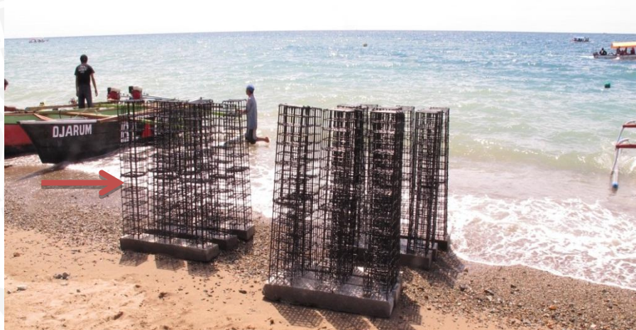
Gambar 12. Bentuk dan Konstruksi Satu Modul Rumah Ikan (Dinas Kelautan dan Perikanan Gorontalo, 2012)
