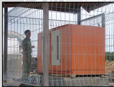
Gambar 15. Genset dan Instalasi
