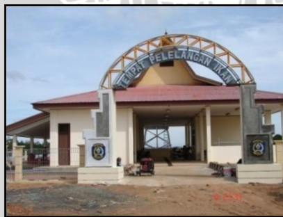
Gambar 9. Gedung TPI Tanjung Limau
