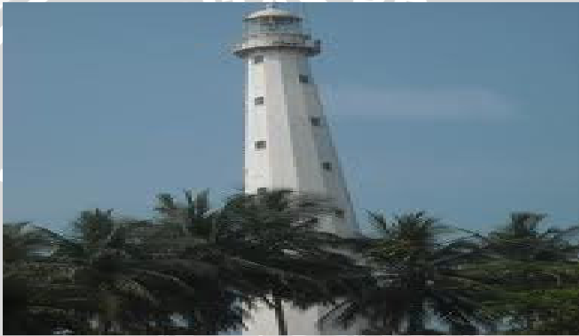
Gambar 11. Menara mercusuar yang tidak berfungsi saat ini
