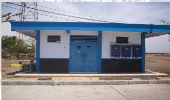
Gambar 15. Gedung Mesin Genset
