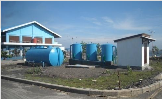
Gambar 18. Instalasi Pengolahan Limbah (IPAL)
