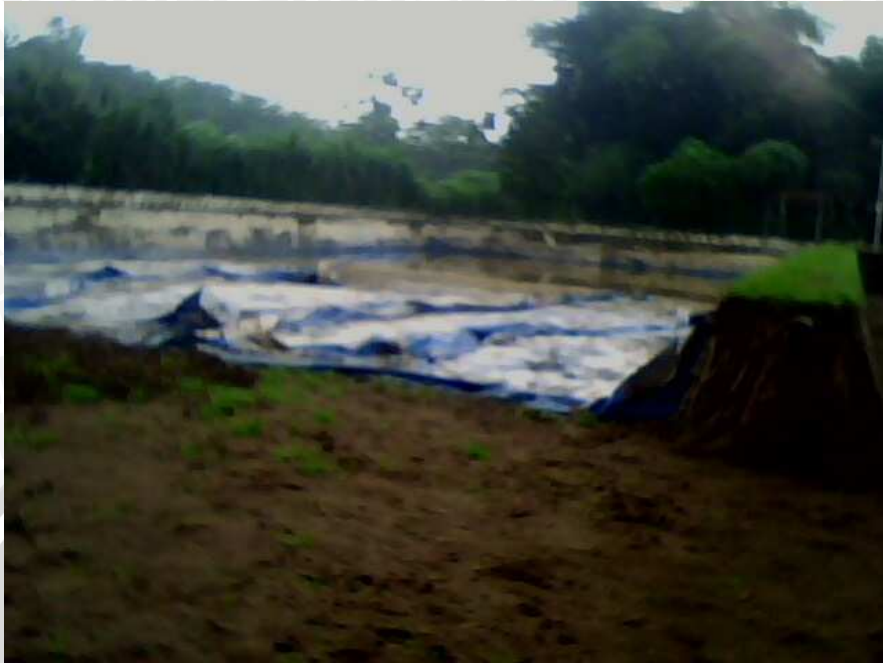
Gambar kolam yang sedang direnovasi
