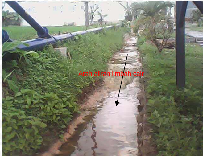
Gambar 16. Saluran utama pembuangan air limbah
