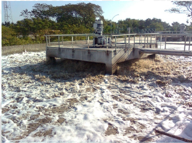
Gambar 14. Tangki aerasi Saat Diberi Aerasi
