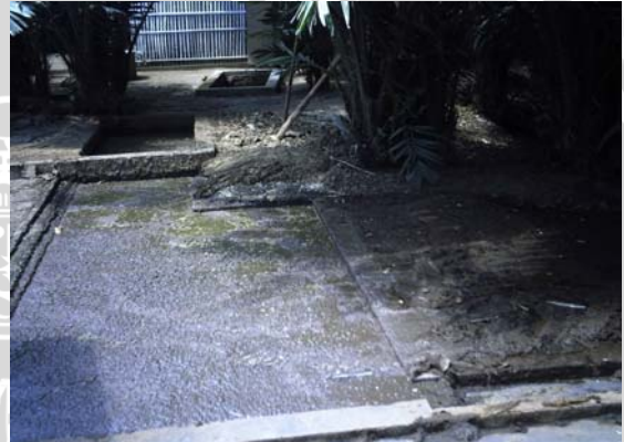
Kolam penampung sludge
