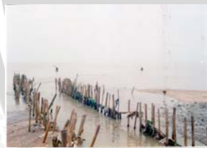
Penjebakan sedimen dengan bambu
