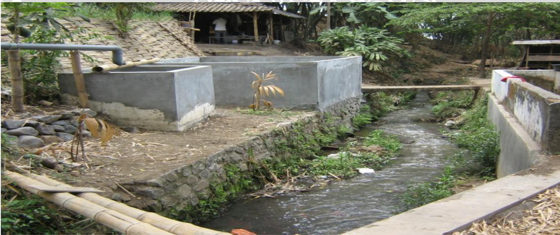
**Gambar 10.** Bak penampungan air yang sudah melalui proses penyaringan
