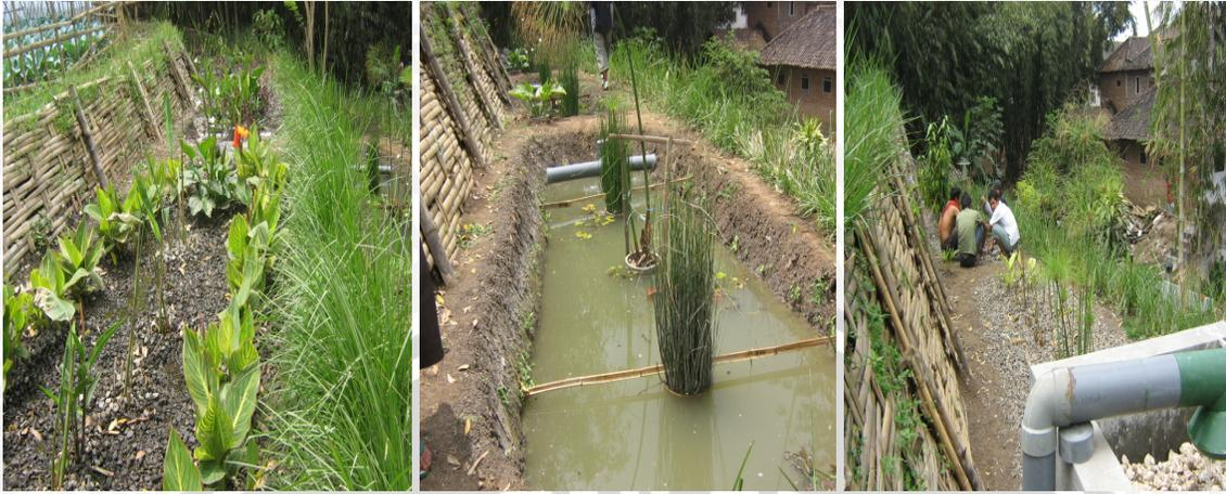
**Gambar 9.** Media tanah, pasir dan batu untuk penyaringan tahap 2a, 2b, 2c “Wet Land“
