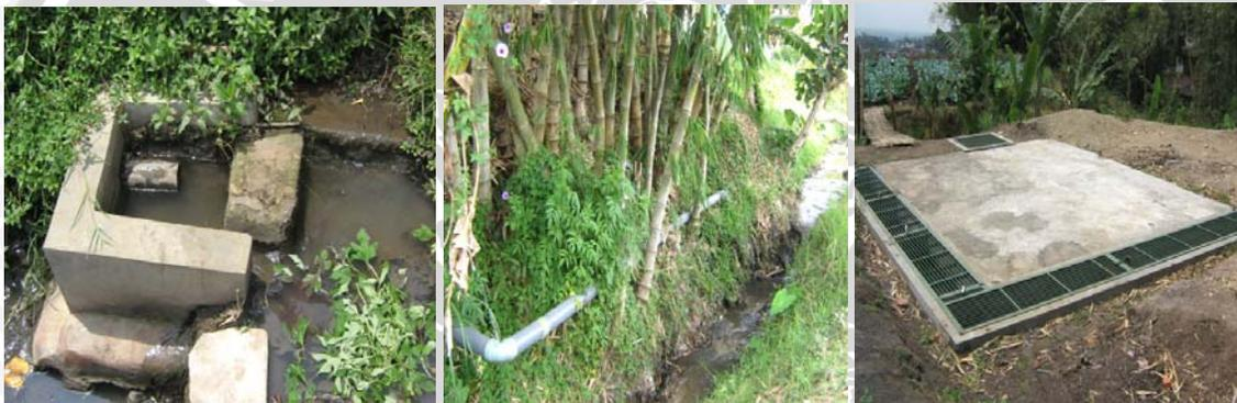
**Gambar 8.** Inlet dan pipa ke Bak Penampungan (*Satelit tank*) limbah pertama dari beton
