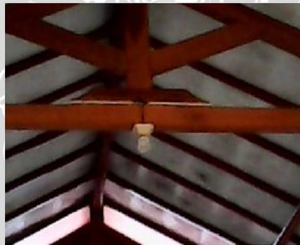
Gambar 11. Lampu Penerangan Tidak Berpenutup.
