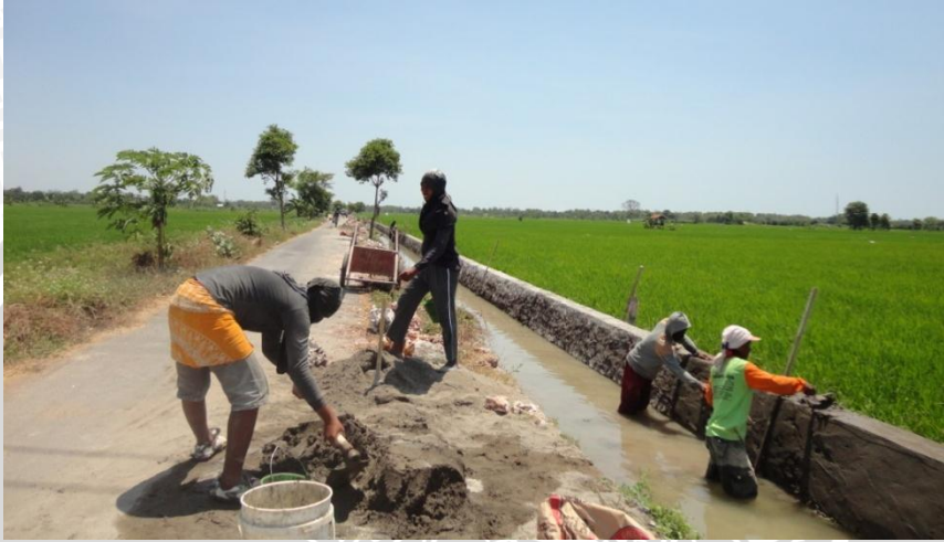
Gambar 12. Pembangunan Saluran Irigasi selama Proses Pelaksanaan PPIP
