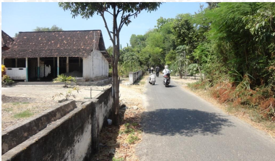
Gambar 14. Kondisi Jalan yang telah Mendapat Bantuan PPIP di Desa Jenu
