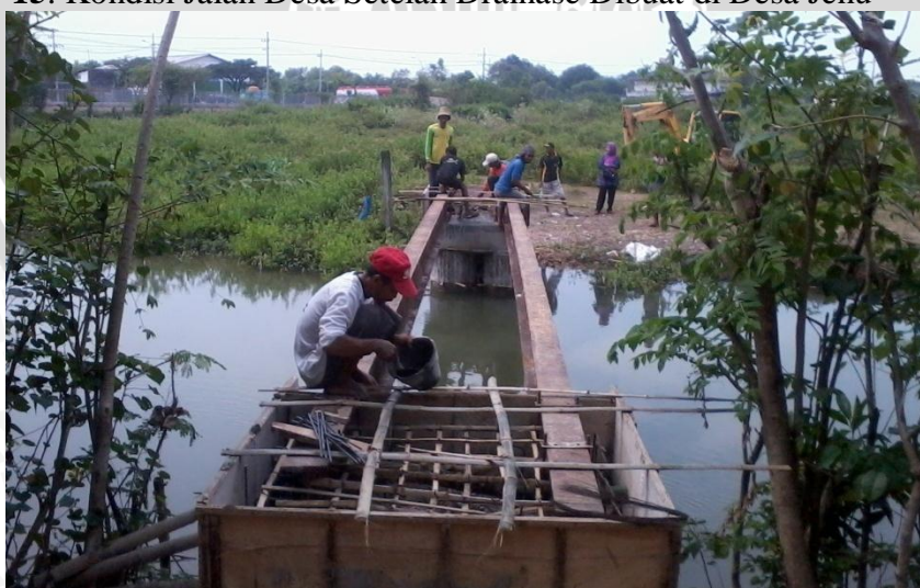
Gambar 16. Pembangunan Jembatan di Desa Jenu
