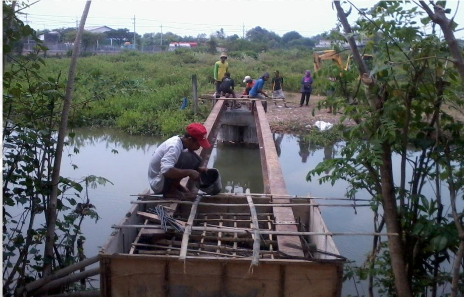
Gambar 5. Pembangunan Jembatan antara Desa Jenggolo dan Jenu
