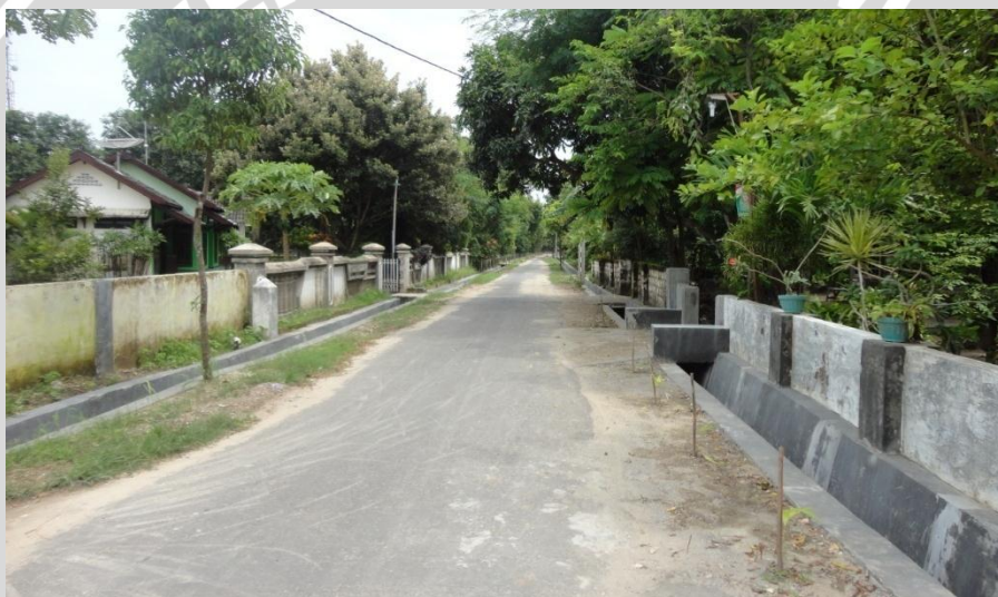
Gambar 15. Kondisi Jalan Desa Setelah Drainase Dibuat di Desa Jenu
