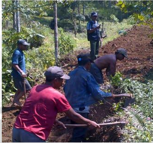
Gambar 3 : Proses Pembuatan Jalan
