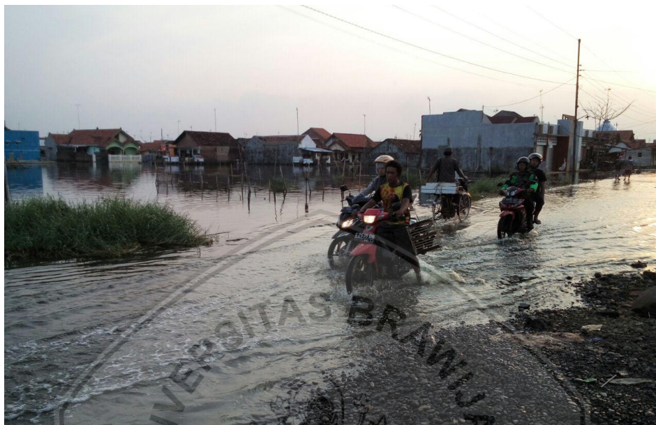
Gambar 30. Sarana Jalan Pemukiman yang Tergenang Banjir Rob
