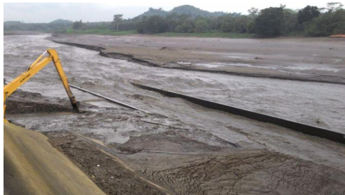
Pengerukan Sedimen dengan alat bantu pada pintu PLTA
