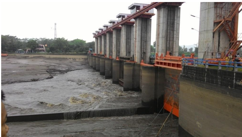
Proses flushing pada Bendung Lodoyo
