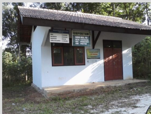
Gambar 12. Bangunan Administrasi Gapoktan Sido Mulyo Desa Tamanasri
