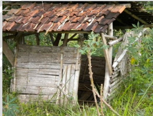
Gambar 9. Fasilitas MCK (WC) yang Kurang Memadai
