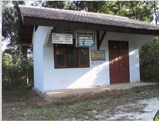
Gambar 5.6 Bangunan Administrasi Gapoktan Sido Mulyo Desa Tamanasri
