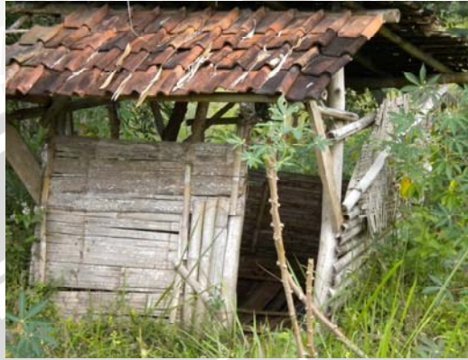
Gambar 5.11 Kondisi Jamban Keluarga yang Tidak Memenuhi Standar Sanitasi
