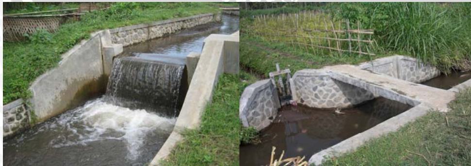
Gambar 5.8 (a) Saluran irigasi sekunder dan (b) Saluran irigasi tersier
