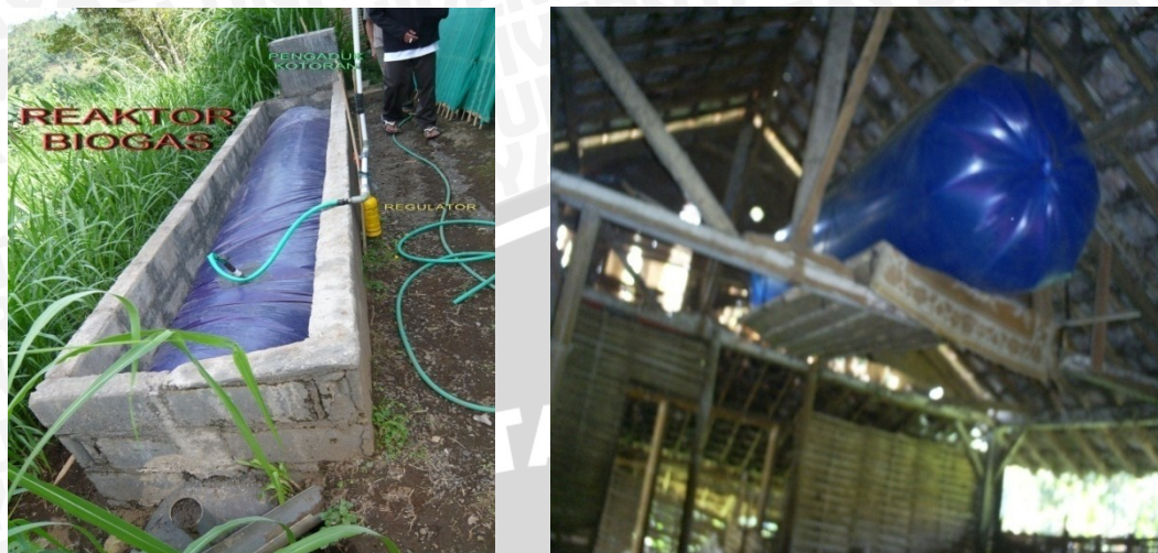
Gambar 8. Instalasi Biogas Skala Rumah Tangga Yang Dikembangkan di Lokasi Prima Tani; Reaktor (a) dan Penampungan Gas (b)
