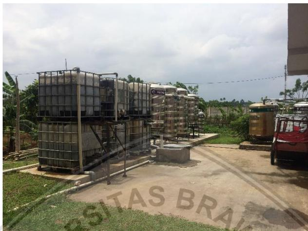
Gambar 4.18 Pemanfaatan sistem air daur ulang untuk irigasi
