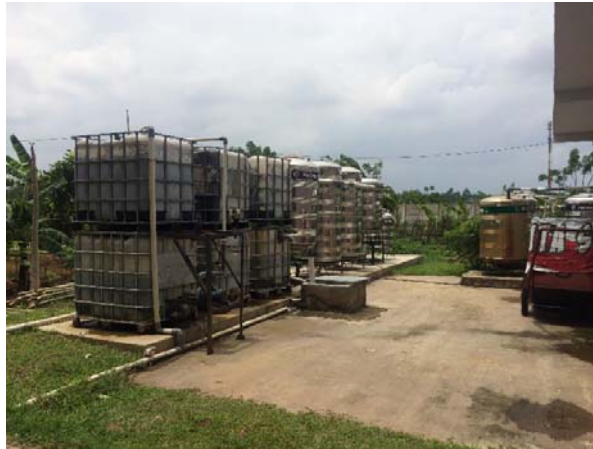
Gambar 4.18 Pemanfaatan sistem air daur ulang untuk irigasi
