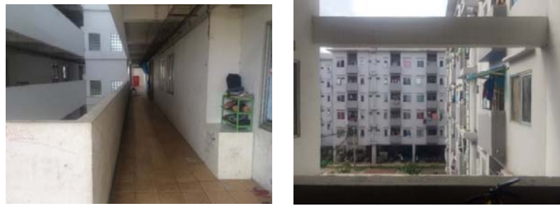
Gambar 4.22 Kondisi eksisting ventilasi di Blok H Rusunawa Pesakih
