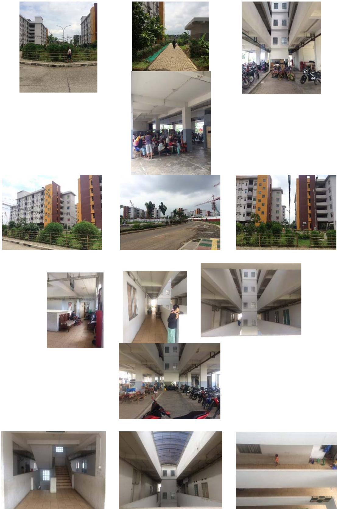
Gambar 4.3 Kondisi ekisting Rusunawa Pesakih
