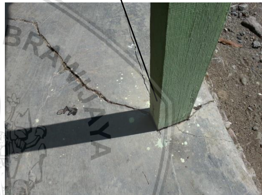
Gambar 4.19 Cagak emper tanpa pondasi umpak
