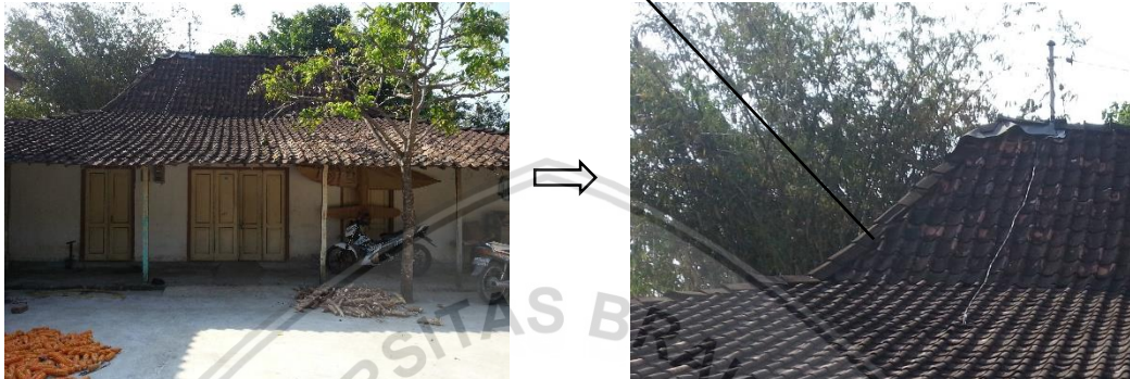
Gambar 4.45 Atap dengan finishing genteng yang hanya diletakkan saja
