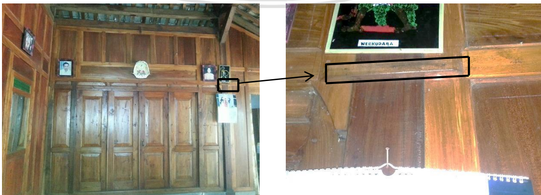
Gambar 4.29 Pemasangan detail boman
