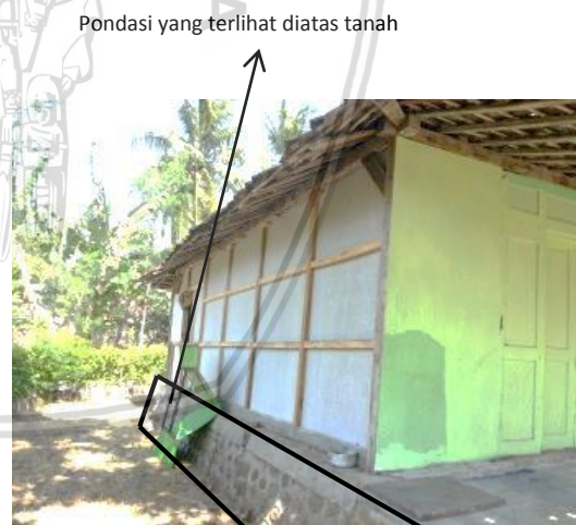
Gambar 4.3 Pondasi yang terlihat
