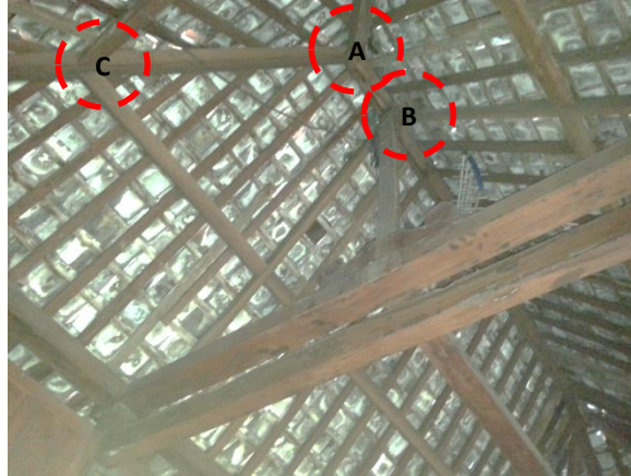
Gambar 4.32 Letak sambungan konstruksi atap varian A
