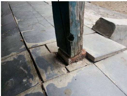
Gambar 4.18 Cagak emper dengan pondasi umpak
