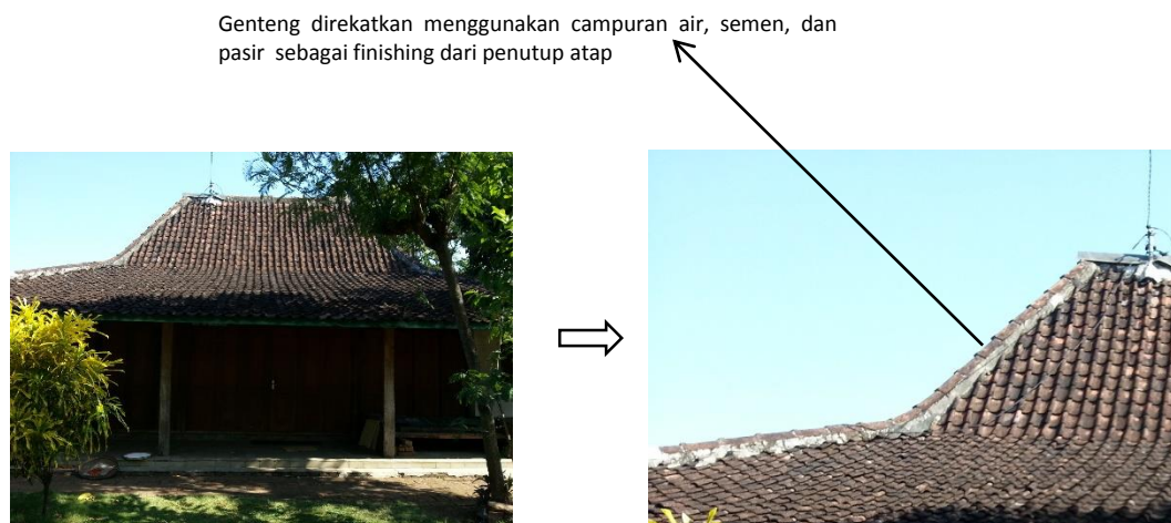
Gambar 4.46 Atap dengan finishing genteng yang diletakkan menggunakan campuran air, semen, dan pasir
