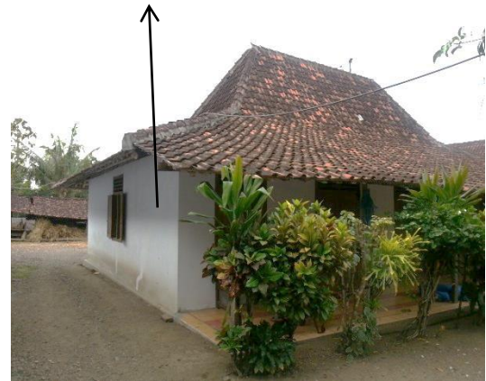
Gambar 4.23 Dinding batu bata dengan plester dan aci
