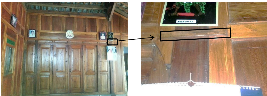
Gambar 4.29 Pemasangan detail boman
