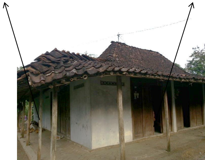
Gambar 4.20 Cagak emper pada rumah sinom
