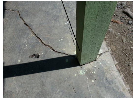
Gambar 4.19 Cagak emper tanpa pondasi umpak
