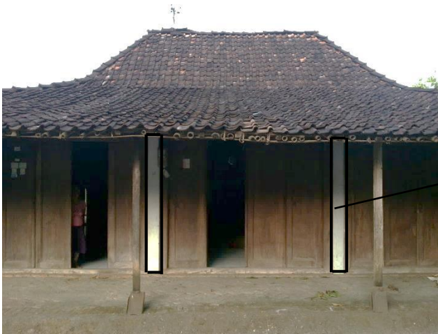
Gambar 4.17 Cagak cor yang terlihat
