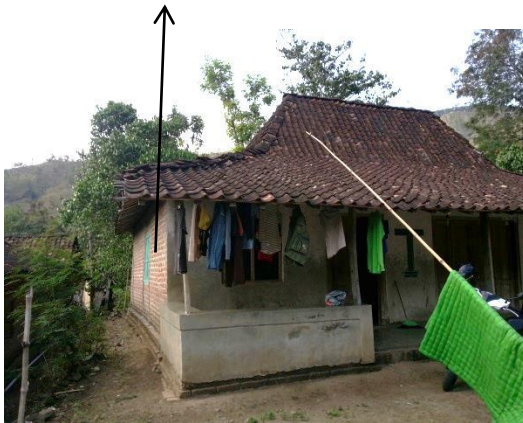
Gambar 4.22 Dinding batu bata tanpa plester dan aci
