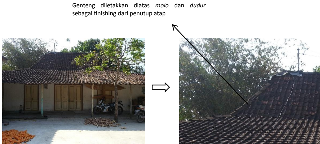
Gambar 4.45 Atap dengan finishing genteng yang hanya diletakkan saja
