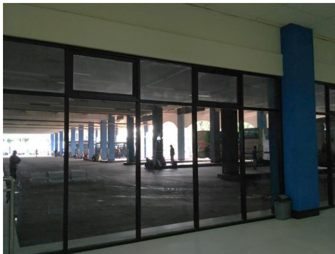
Gambar 4.20 Jendela pada Objek Studi (dokumentasi foto)
