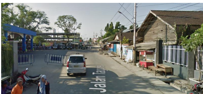
Gambar 4.5a Kondisi Bangunan Sekitar Ruang Tunggu Timur Terminal Tirtonadi sumber: https://google.co.id/maps/
