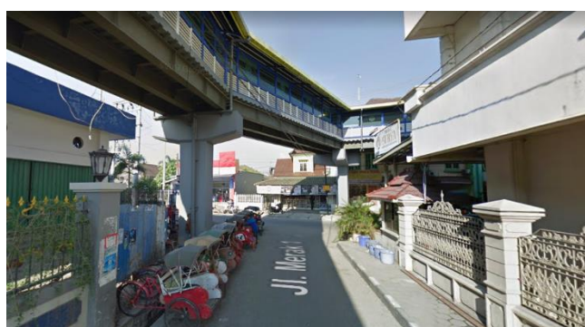
Gambar 4.5b Kondisi Bangunan Sekitar Ruang Tunggu Timur Terminal Tirtonadi sumber: https://google.co.id/maps/
