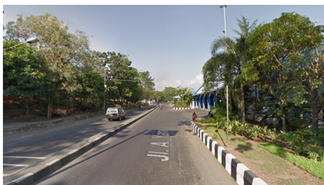
Gambar 4.9a Kondisi Bangunan Sekitar Ruang Tunggu Barat Terminal Tirtonadi sumber: https://google.co.id/maps/
