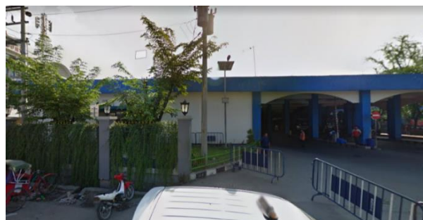
Gambar 4.3 Sisi Timur Ruang Tunggu Timur Terminal Tirtonadi sumber: https://google.co.id/maps/
