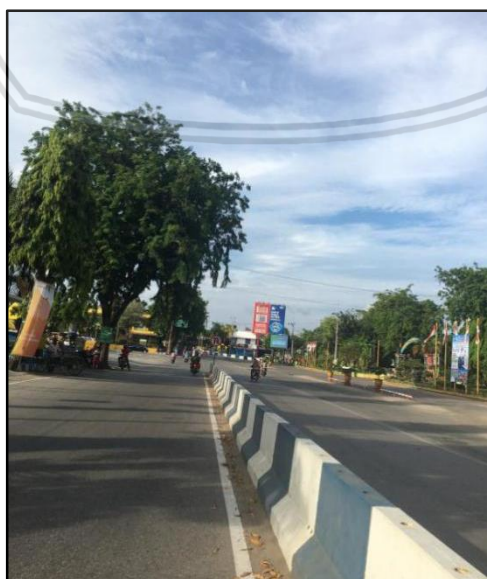
Gambar 4.13 Kondisi Jalan Nasional di Wilayah Studi
