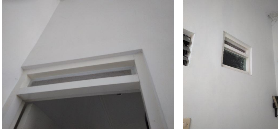
Gambar 4. 48 Ventilasi pada kamar mandi sampel 3
