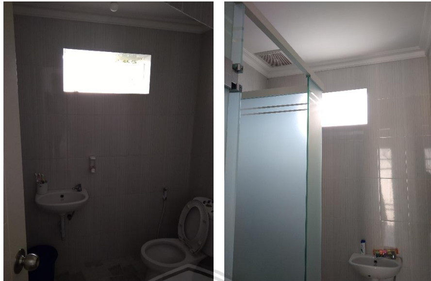
Gambar 4. 46 Ventilasi pada kamar mandi sampel 1
