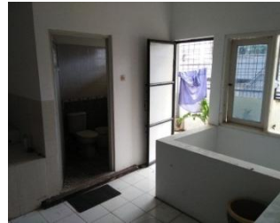
Gambar. 4.305 Toilet dan Ruang Jemur Lantai 2 Objek
