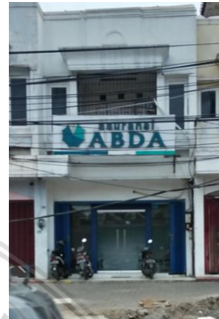
Gambar 4.201 Tampak Bangunan Objek C
