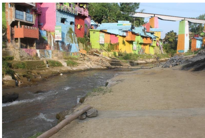
Gambar 4.1 Kondisi Sempadan Sungai di RT 07 Kampung Warna-warni Jodipan (Dokumentasi pribadi)
