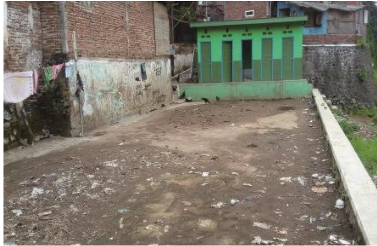
Gambar 3.2 Kondisi di Sekitar Lokasi MCK Sebelum Program CSR Berupa Pengecatan (Sumber: Guyspro)
