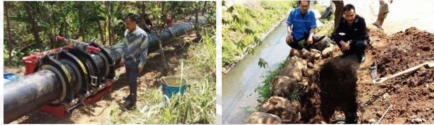
Gambar 4.9 Pembangunan Sistem Pompa Gravitasi
