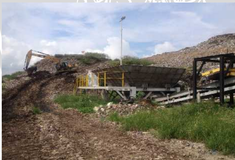
Ket : Sampah yang akan di proses dengan menggunakan excavator menuju hopper
