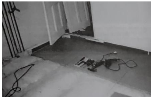
Gambar 2.17 Rangka lantai raised floor diisi selimut akustik dan ditutup papan Sumber: Mediastika, 2009
