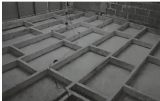
Gambar 2.16 Rangka lantai raised floor dari kayu Sumber: Mediastika, 2009
