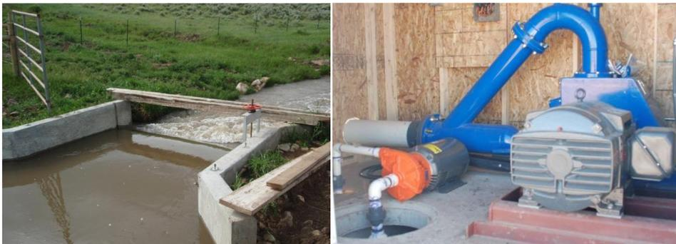
Gambar 2.3 Pembangkit tenaga mini hidro pada saluran air
