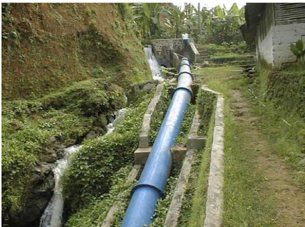
Gambar 2.43 Pipa Pesat (*Penstock*)
