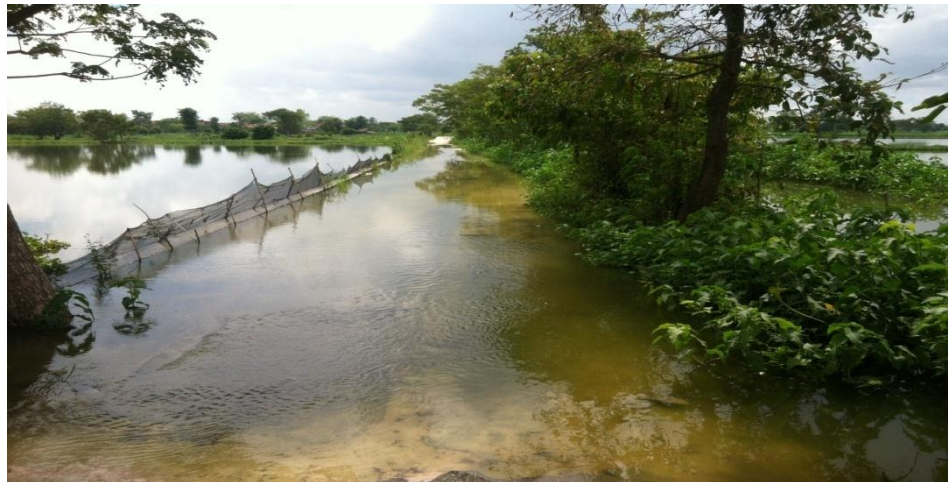
Gambar 12. Akses Jalan Desa Bojoasri yang Terendam Banjir Sumber: Dokumentasi data peneliti dan Data Sekunder
