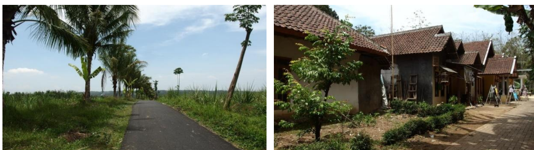
Gambar 4.27 Akses Sudah Diberi Material Perkerasan
