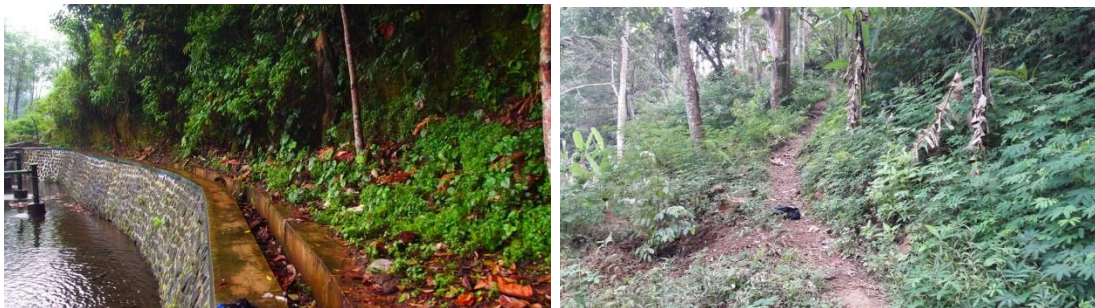
Gambar 4.31 Kondisi Akses Menuju Reservoir dan Gazebo
