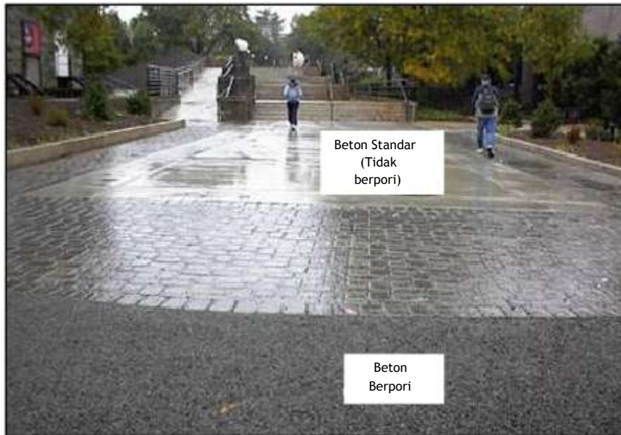
Gambar 3.8. Perkerasan Permeabel - Aspal Permeabel dan Beton Permeabel
