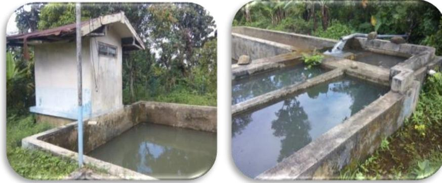
**Gambar 4.8 Sistem Penyediaan Air Minum Dengan Sistem Gravitasi pada Bak Penampung Dusun Sagi**
