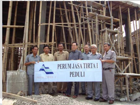
Gambar 14. Pelaksanaan Pembangunan Musholah
